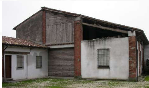
Prima sede di ACTIVE nel 1991 presso la Cascina di proprietà del Padre di Griffini Alberto
